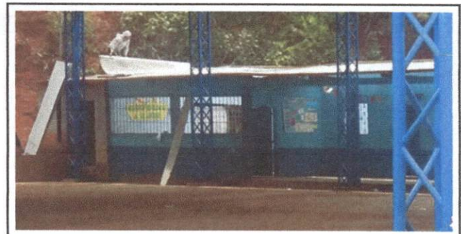
Foto 6: Eliminación de laminas sobre puestas en mal estado.
