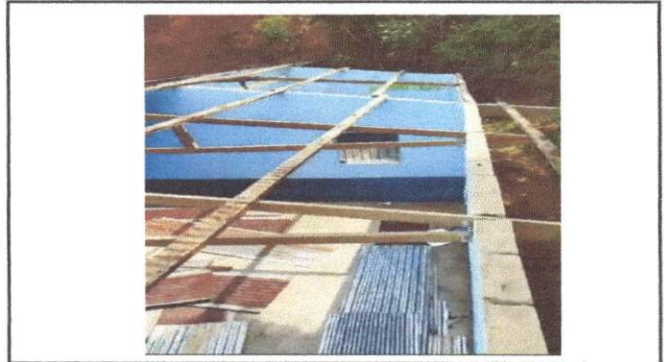
Foto 2: eliminacion de los tendales de madera.
