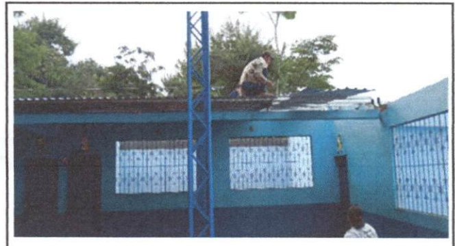
Foto 4: Colocación de estructura metalica.
