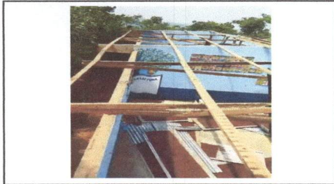
Foto 1: quitaron las laminas en mal estado
